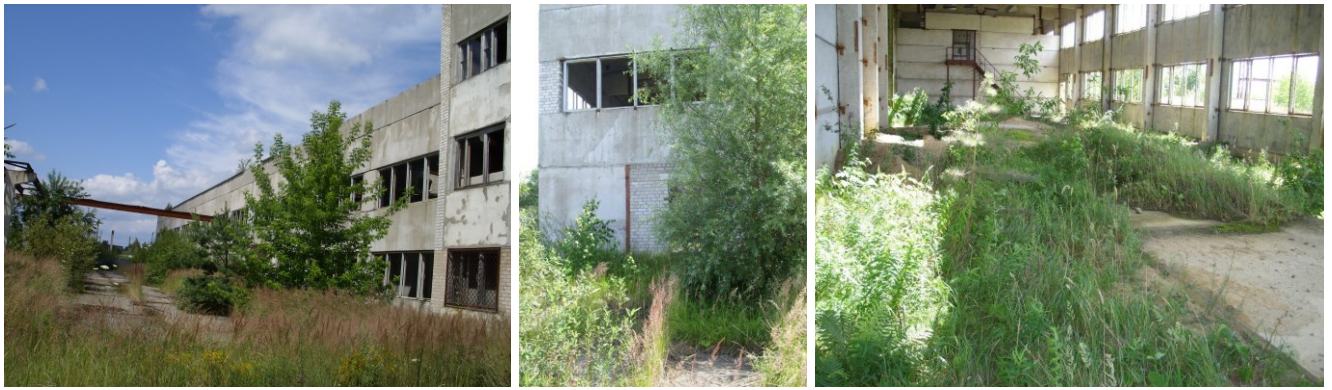
Рисунок 1. Корпус механических мастерских до начала реконструкции (22.07.10г.)
